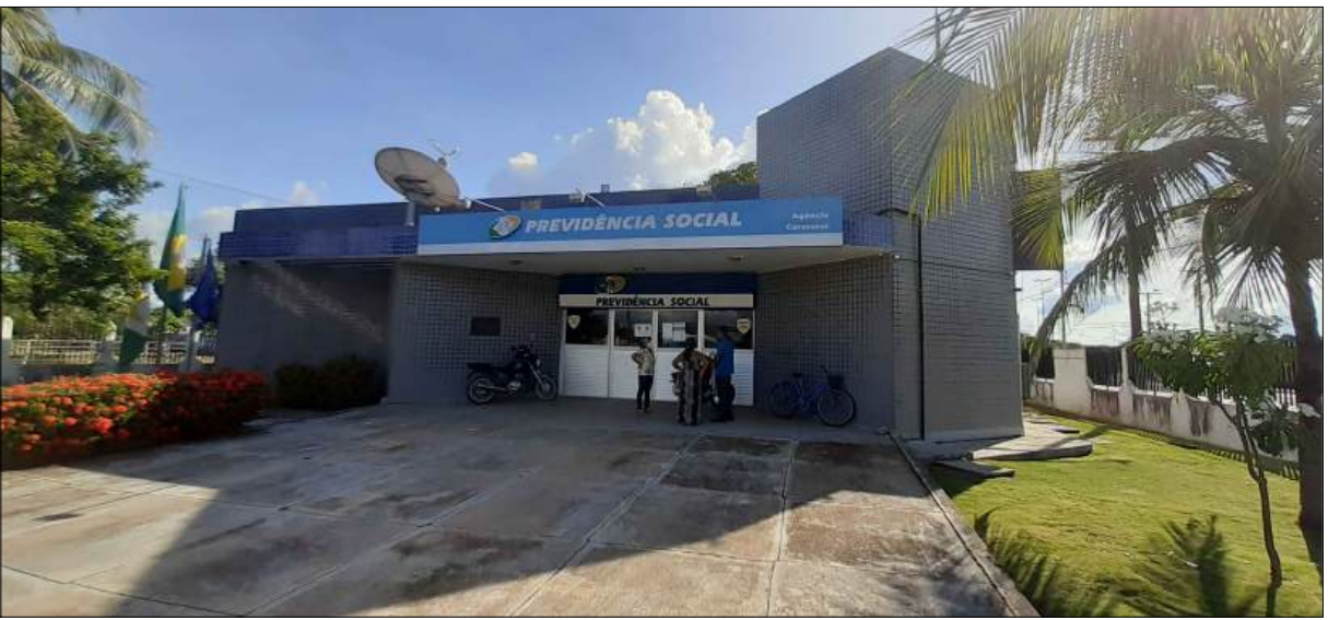
FOTO 09 - EXTERIOR (PÁTIO DE ACESSO FRONTAL)
