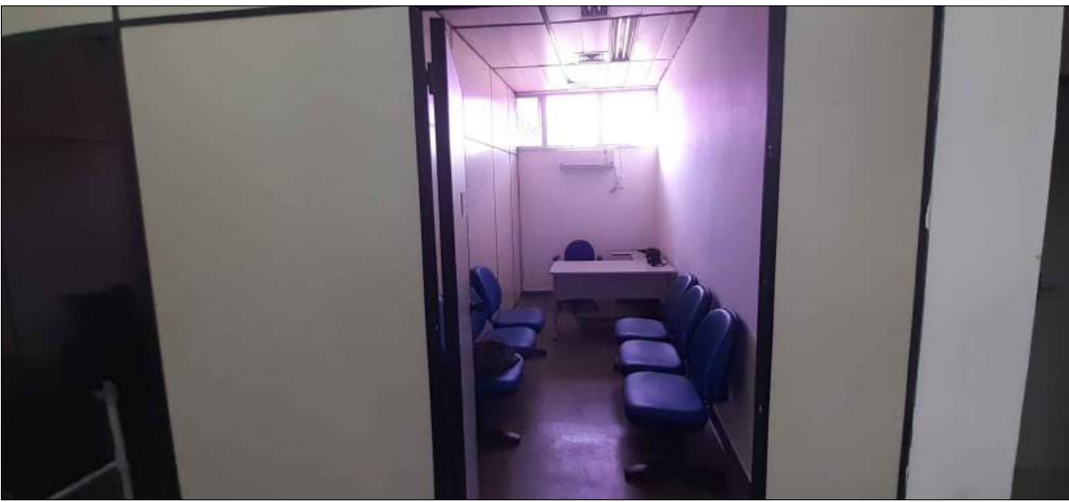
FOTO 16 - VISTA ATUAL - DIVISÓRIAS - SERVIÇO SOCIAL
