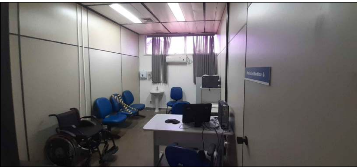
FOTO 15 - VISTA ATUAL - DIVISÓRIAS - PERÍCIA MÉDICA
