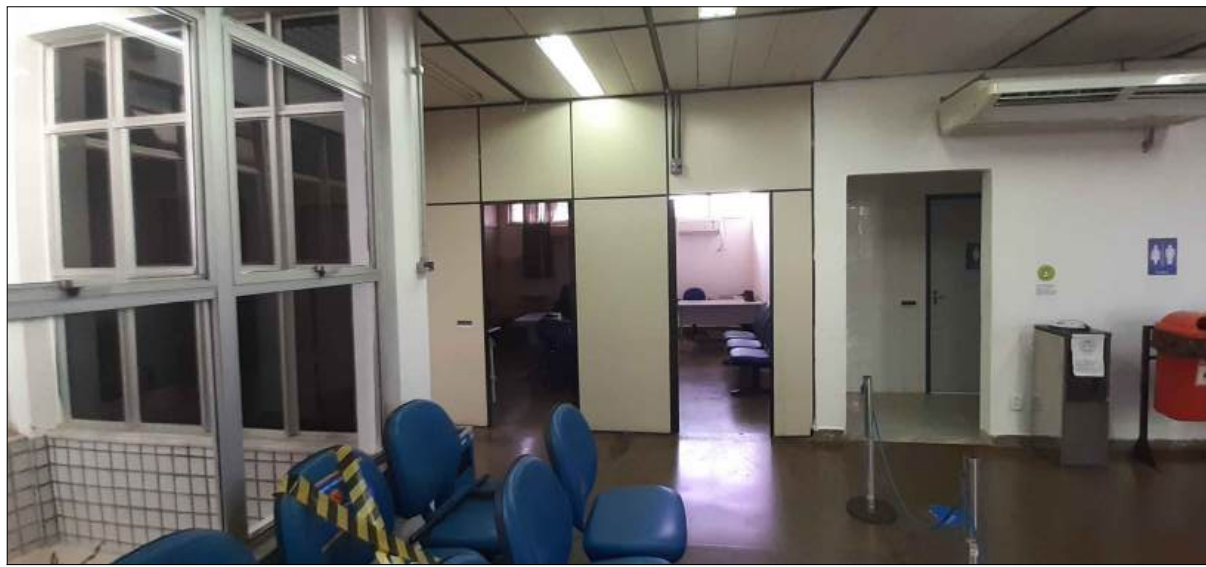
FOTO 17 - VISTA ATUAL - DIVISÓRIAS / PORTAS
