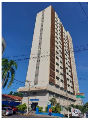
Foto 01 - Prédio Sede da Gerência Executiva em Cuiabá
