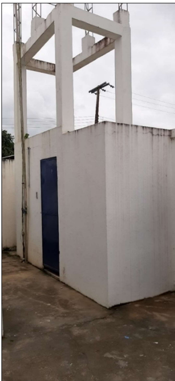
Det. deposito e pilares de sust. dos res. superior
