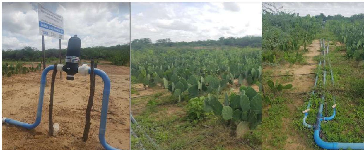
Figura 82 - Componentes do sistema de irrigação da Unidade de tratamento de reuso de efluentes domésticos do município São Fernando-RN.
