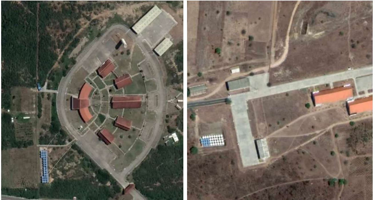
Sistemas de armazenamento, tratamento e distribuição de água de chuva, na Sede Administrativa e Estação Experimental
