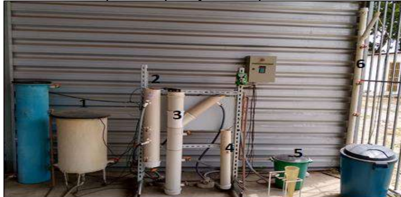
Sistema anammox (1- Tanque de equalização para efluente do UASB; 2- RBS1; 3- RH; 4-Tanque equalização RH; 5- Recipiente para coletar amostra; 6- Reator Anammox).
