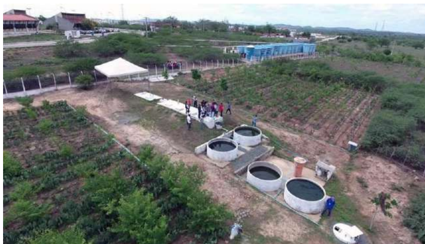
Ampliação do sistema de tratamento da sede do INSA.
