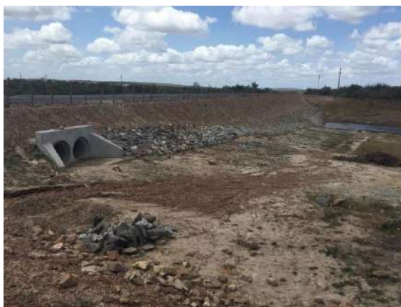
Rodovia com barramento do Açude Preto (recuperado)
