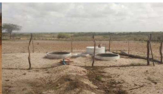
Sistema de tratamento de águas residuárias. Família experimentadora: Sara Maria Constâncio
