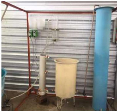
Unidade de floculação e decantação.
