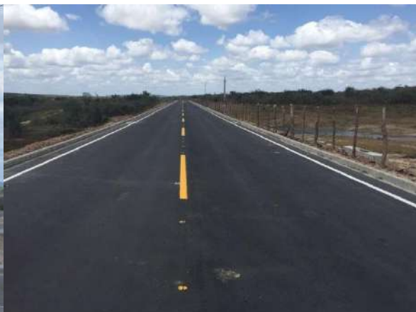
Trecho pavimentado da rodovia
