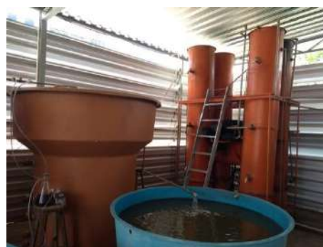
Foto dos Reatores UASB (a) recebe esgoto municipal; (b) recebe esgoto condinial.
