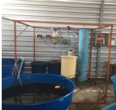
Vista geral do sistema em operação.
