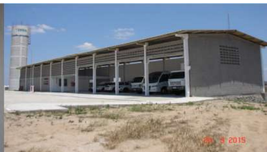
Vista da garagem e depósito
