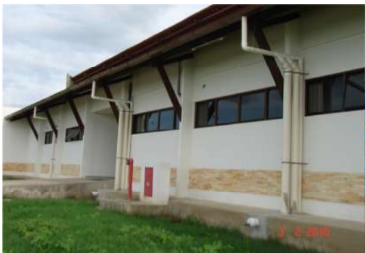
Dispositivos de descarte do 1º milímetro de chuva
