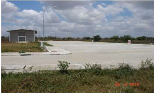
Vista externa da casa do trabalhador e infraestrutura
