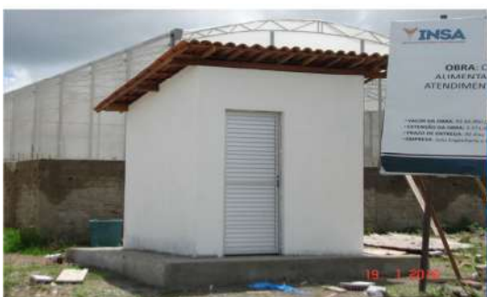
Casa de bombas para casas de vegetação
