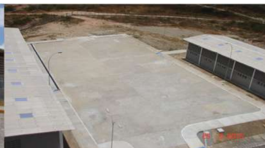
Vista aérea dos blocos e pátio de manobra
