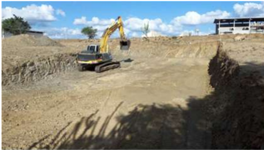
Escavação para lastro dos reservatórios
