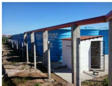
Conjunto de reservatórios para água de chuva Reservatórios e casa de bombas
