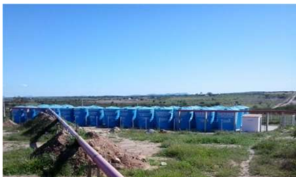
Conjunto de reservatórios para água de chuva Reservatórios e casa de bombas
