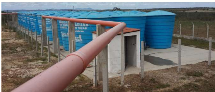
Sistema de abastecimento de água da sede do INSA baseado na captação de água de chuva
