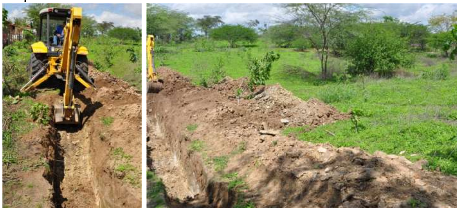
Construção da barragem subterrânea
