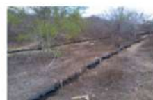
Implantação de 150 m de Tratamento Linear com Revestimento de PVC.
