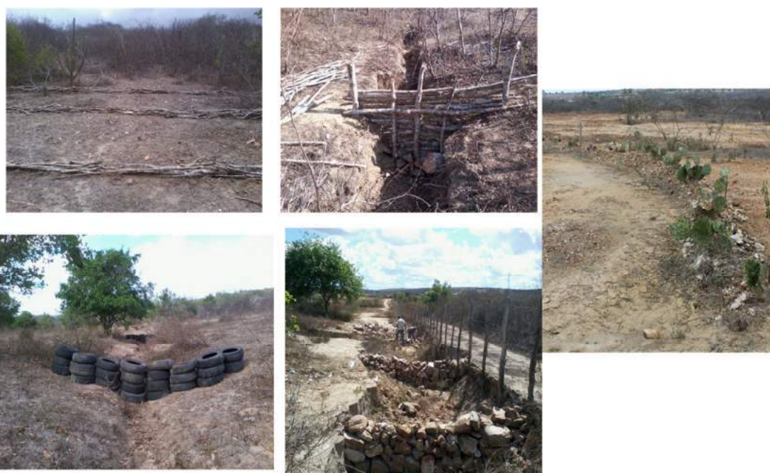
Figura 34. Mini-estrutura de caráter mecânico, físico e biotecnológico de conservação e recuperação de solo, água a nível de propriedades familiares.
