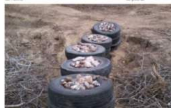
Implantação de 12 unidades Tratamento Linear com "Ramos de Pedra".
