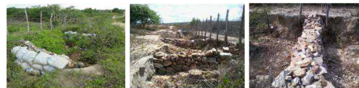
Uma destas tecnologias é a de montar pequenas represas através do empilhamento de pedras ou sacos. O Insa já instalou mais de 100 destas represas.
