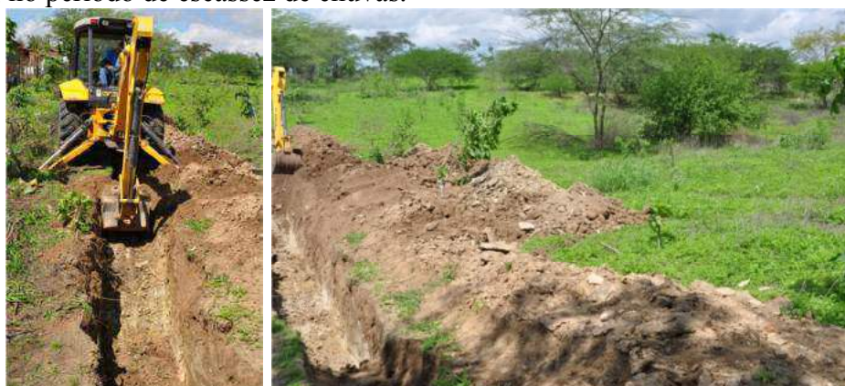
Construção da barragem subterrânea
