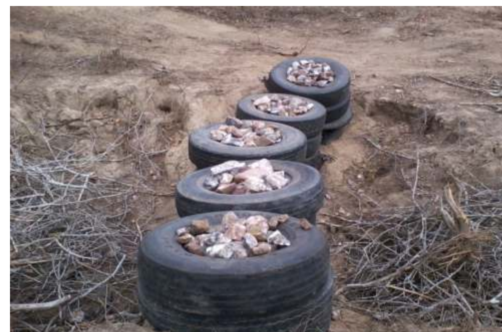
Implantação de mais de 100 unidades Represa com estrutura de pedras
