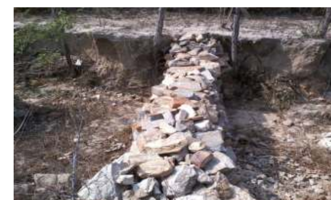
Implantação de mais de 100 unidades Represa com estrutura de pedras
