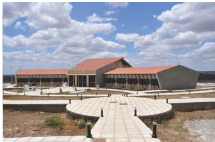
Conclusão do Centro de Treinamento, composto de biblioteca, salas e auditório com capacidade para 130 pessoas
