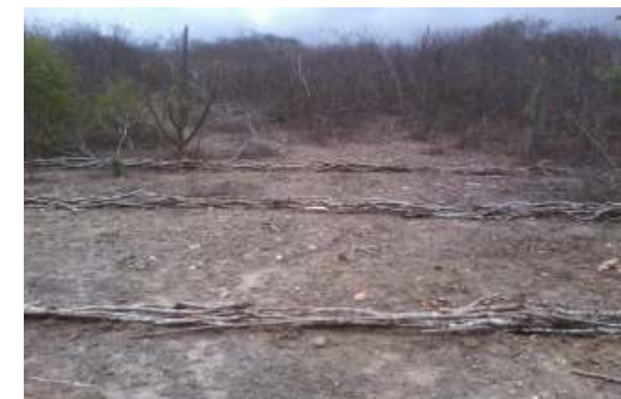
Implantação de 300 m de Tratamento Linear com “Cerca de Faxina”
