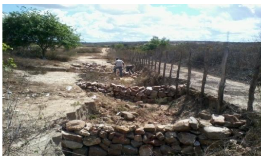
Implantação de mais de 100 unidades tipo: Represa com estrutura de pedras
