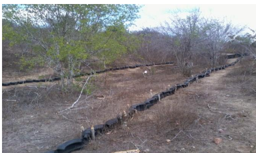
Implantação de 150 m de Tratamento Linear com Revestimento de Pneus.
