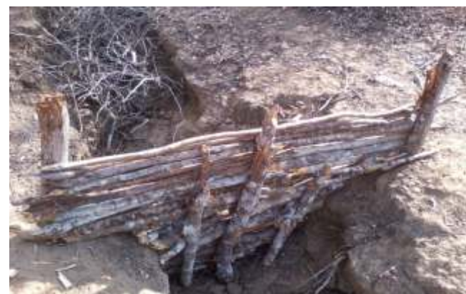
Implantação de 15 unidades Tratamento Linear com “Ramos de Faxina”
