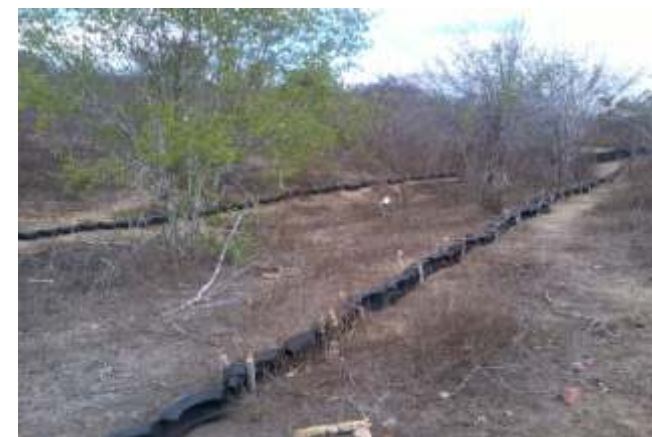
Implantação de 150 m de Tratamento Linear com Revestimento de Pneus.
