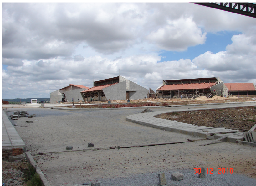
Figura 4 – Vista panorâmica do arruamento e Blocos ao fundo em fase final de construção
