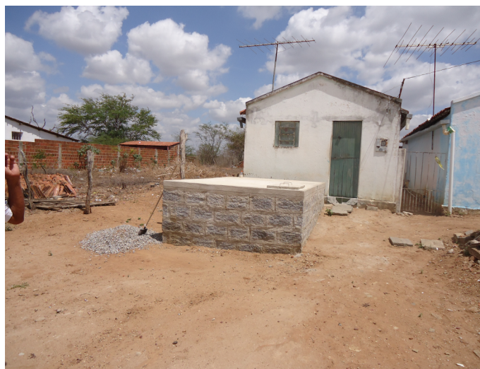
Cisterna produzida com pedra - Distrito Catolé de Boa Vista - Campina Grande - PB
