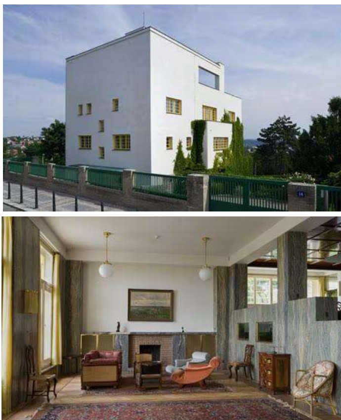
Figura 46 - Villa Müller, em Praga, por Adolf Loos, 1928-30. Exterior (acima) e interiores (abaixo).
