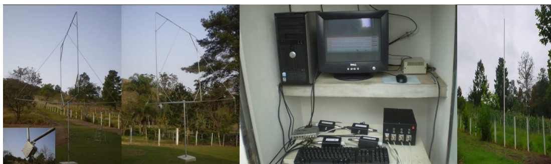
Figura 2.2 – Equipamento da estação receptora de ondas de VLF da rede SAVNET instalado no Rádio Observatório do Itapetinga (ROI), Atibaia.
