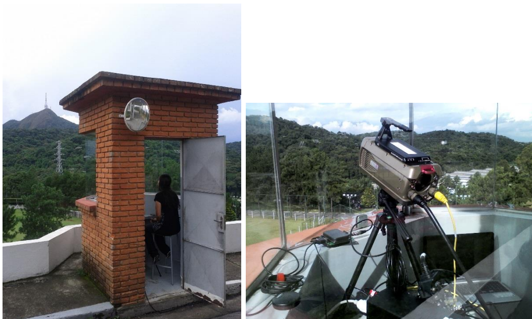
Figura 3.13 Câmeras instaladas na estação do SBT
