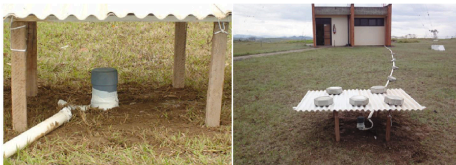
Figura 3.3 - Exemplo de magnetômetro da Rede do Clima Espacial instalado em Cachoeira Paulista.
