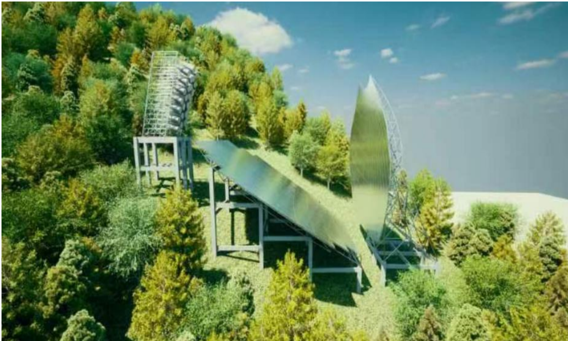
Figura 3.2: Representação artística do arranjo do sistema óptico do radiotelescópio BINGO no seu sítio na Serra do Urubu.
