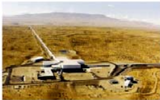
LIGO Hanford WA (4km & 2km)
