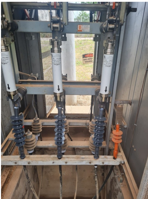
Figura 1 - Mufas substituídas e fusíveis substituídos
