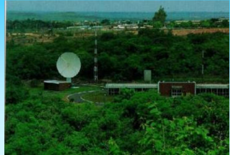
Estação Terrena de Cuiabá (MT)
