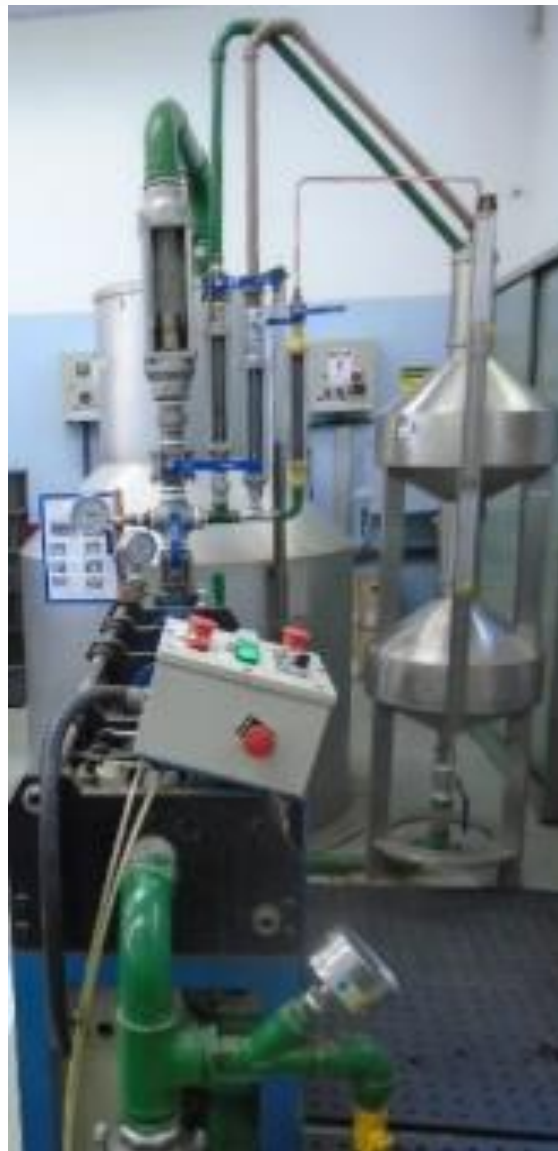
Figura A2 – Bancada de Calibração de Hidrômetros da Empresa - Itron
