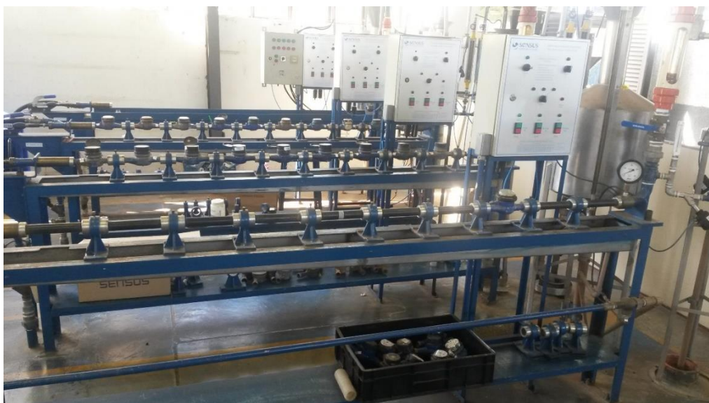
Figura A2 –Bancada de Ensaio de Hidrômetros da Empresa - CAESB
