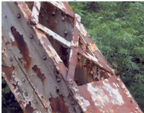
Figura 10 – Ponte pintada com tinta à base de chumbo
