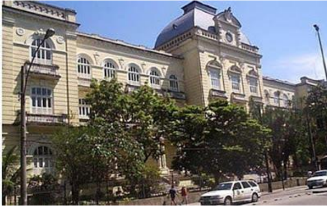
Sede do INES, no bairro de Laranjeiras, Rio de Janeiro/RJ.
