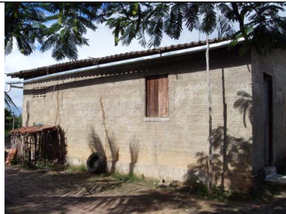
FOTO 20: VISTA DE UMA HABITAÇÃO DO ELDORADO DOS CARAJÁS FONTE: GERAH
