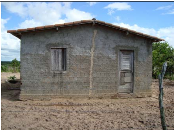
FOTO 19: VISTA DE UMA HABITAÇÃO DO ELDORADO DOS CARAJÁS FONTE: GERAH
