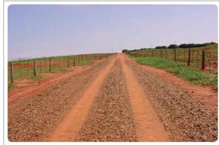
Figura 19: Segregação de material aplicado
