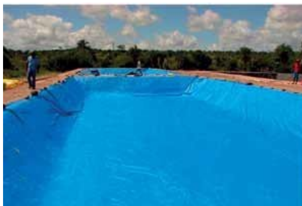
Figura 7: Processo de aplicação da geomembrana (passo 4).
