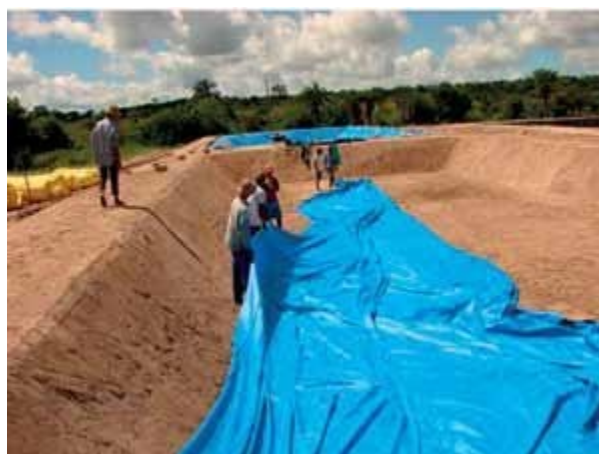
Figura 5: Processo de aplicação da geomembrana (passo 2).
