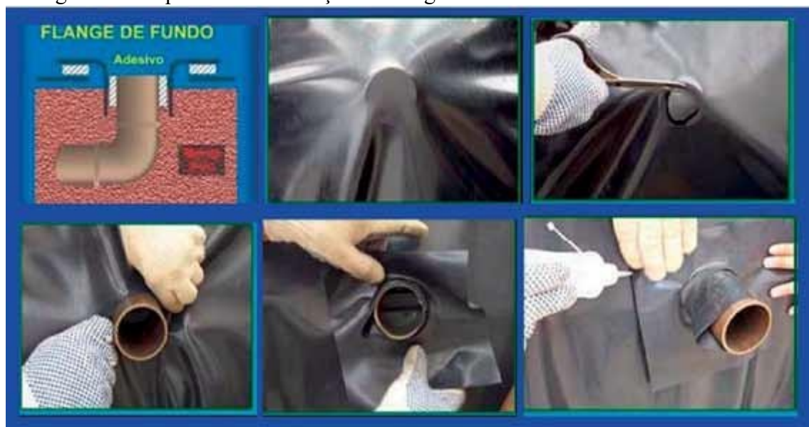
Figura 11: Sequência da colocação do flange de fundo do viveiro.
