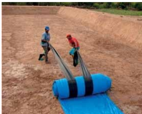
Figura 4: Processo de aplicação da geomembrana (passo 1).
