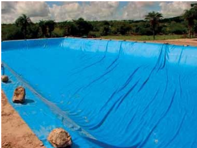
Figura 8: Lastreamento da geomembrana na vala de ancoragem.
