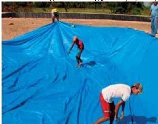
Figura 6: Processo de aplicação da geomembrana (passo 3).
