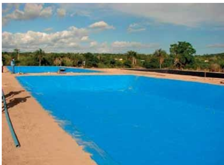
Figura 9: Fixação da geomembrana na vala de ancoragem.
