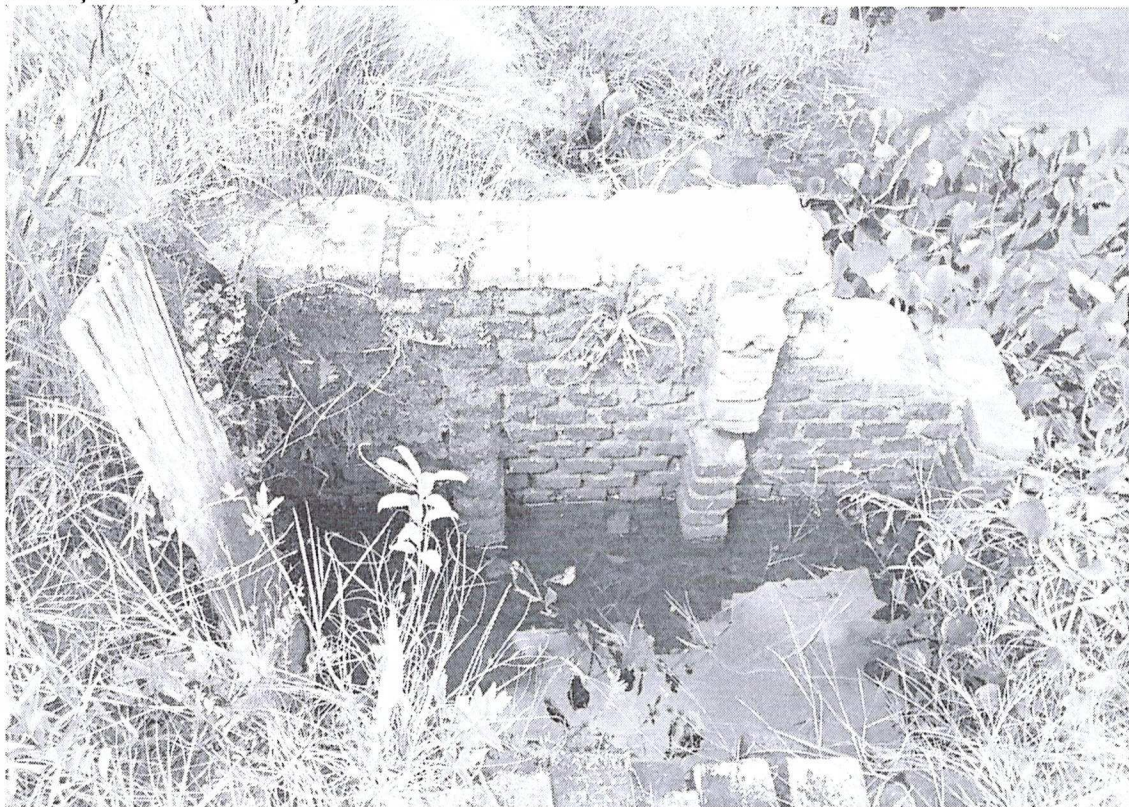
Figura 2. Presença de excessiva vegetação no vertedouro 1, que apresenta péssimas condições de manutenção e funcionamento.
