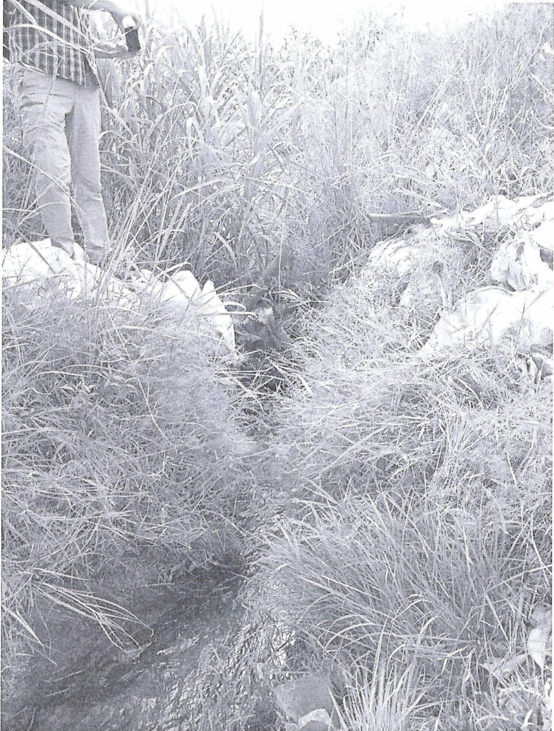
Figura 6. Canal de tomada d'água para irrigação em desuso e em péssimas condições de manutenção.
