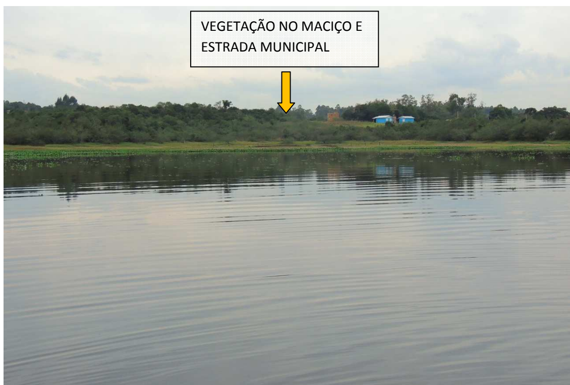
Fig 6: Barragem de baixo: Visão de jusante para montante e ,ao fundo, a vegetação existente no maciço da barragem de cima.
