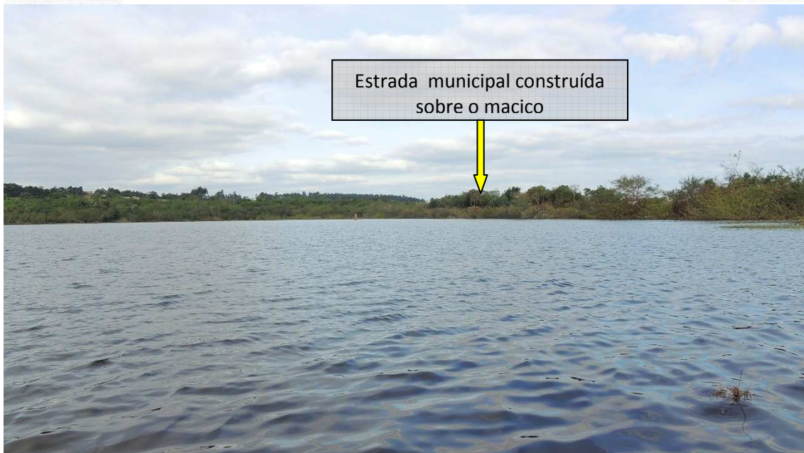
Fig 1: Barragem de cima: Visão de montante para jusante, com vegetação arbórea no maciço sobre o qual há uma estrada municipal.
