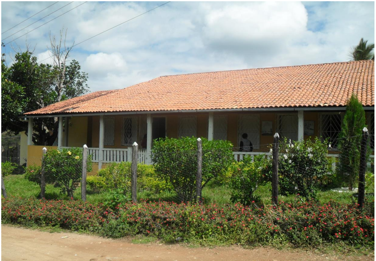
Figura 21 – Prédio da Escola Técnica em Jequitibá
