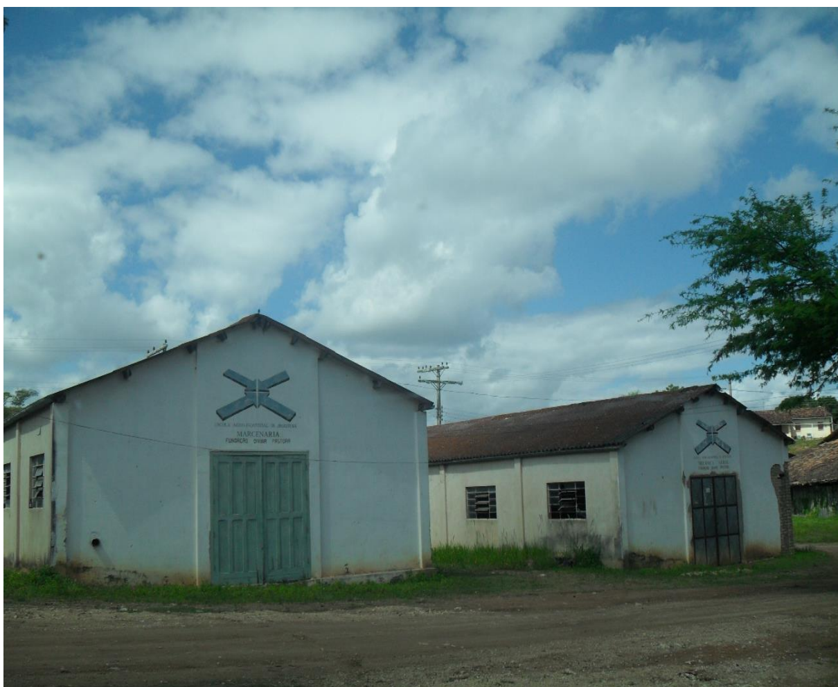
Figura 18 - Faixada frontal de galpões da Fazenda Jequitibá
