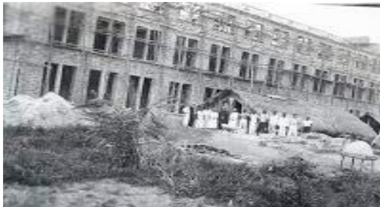
Figura 6 - Construção do Mosteiro de Jequitibá
