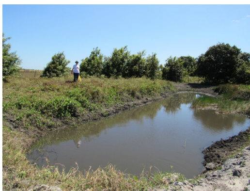
e) Coleta de Amostra de água no Ponto AC 03 em escavação no leito do Riacho Jambolão.
