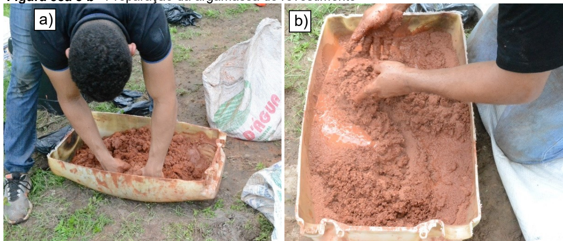
Figura 38a e b- Preparação da argamassa de revestimento
