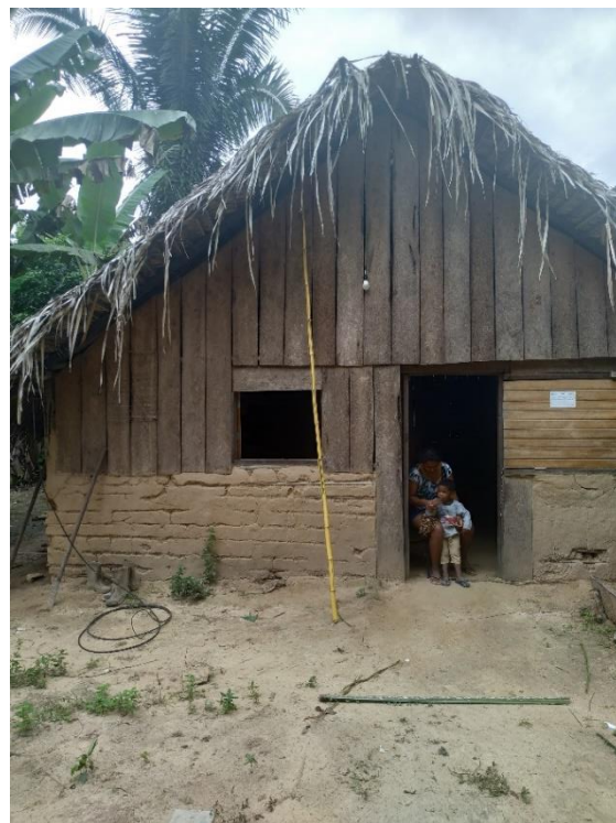
Fotografia 14 – A casa de babaçu
