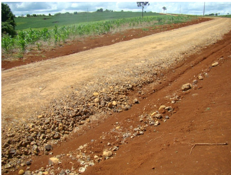
Ilustração 1: Obra de recuperação de estradas vicinais concluída no assentamento 10 de Maio, município de Rio Bonito do Iguaçu/PR
