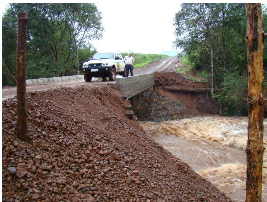
Ilustração 2: Obra de construção de pontes concluída no assentamento Celso Furtado, município de Quedas do Iguaçu/PR
