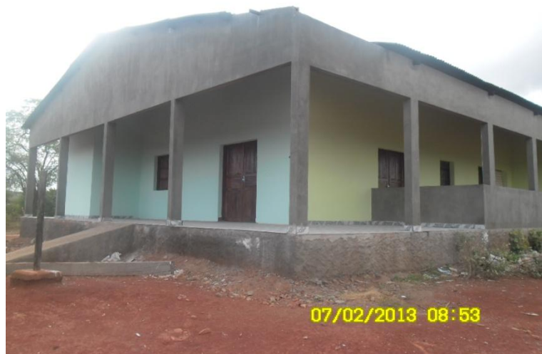
FOTO 6 ã POUSADA (REFORMA CASA SEDE) PA BAIXÃO ITAETÊ
