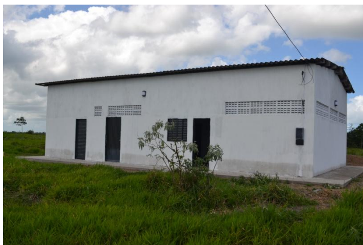
FOTO 7 ã UNIDADE DE FRUTAS (ADEQUAÇÃO DE GALPÃO) ã PA NOVA SUIÇA ã SANTO AMARO
