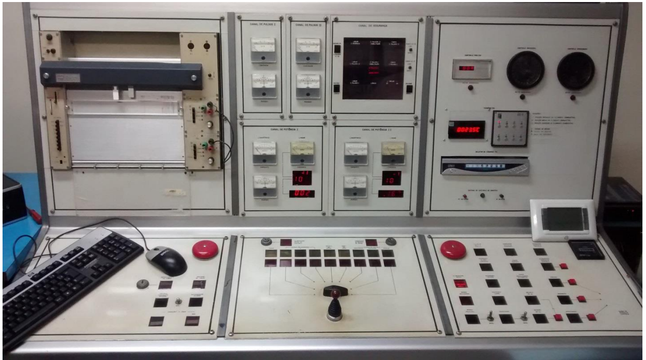
Figura 21 – Mesa de controle do Reator Argonauta (acervo pessoal)
