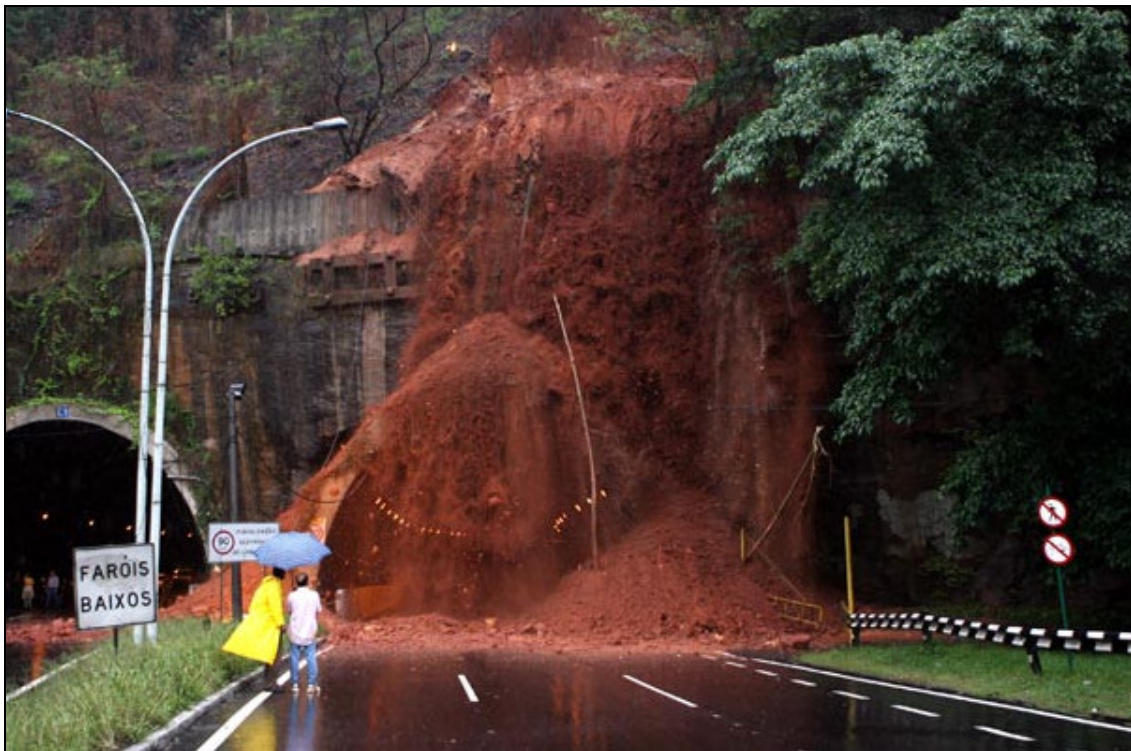
Figura 8: Foto do deslizamento da encosta na entrada do túnel Rebouças.
