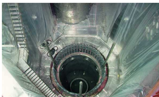
Figura 7 - Suporte do Vaso de Pressão do Reator da Usina Nuclear de Angra 2 instalado no prédio do reator
