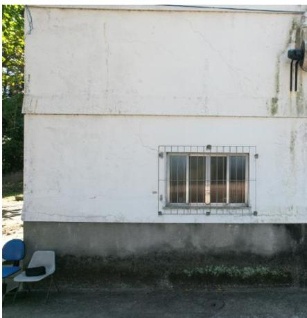
Algumas trincas indicam um pequeno recalque distorcional na viga baldrame da alvenaria de fechamento lateral do pano sul. Trata-se de uma trinca passiva (estável), sem maiores riscos para a estrutura.
