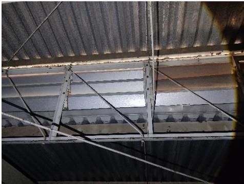
Verificamos que a estrutura do telhado está totalmente estável, porém, há pontos de corrosão por oxidação do aço e alguns pontos com perda seção que precisam de substituição. Com as devidas correções NÃO haverá riscos a longo prazo para a superestrutura.
