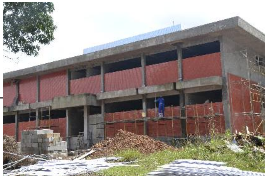
Construção do prédio da Hepatologia, unidade de microscopia eletrônica e curso técnico de laboratório
