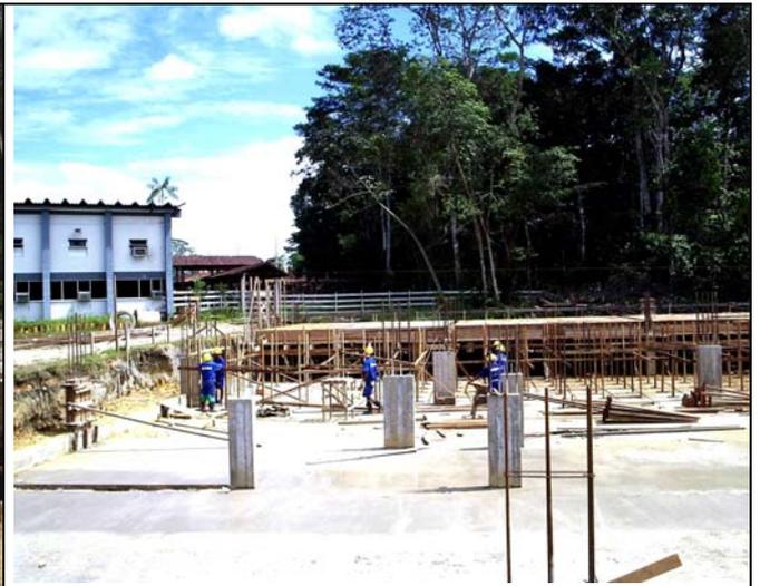
Na frente, o piso do porão do laboratório NB3. Ao fundo, parte da 1ª laje concretada.
