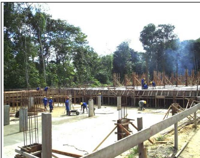
Vista Panorâmica da obra. Na frente pilares concretados do pav. térreo do NB3.
