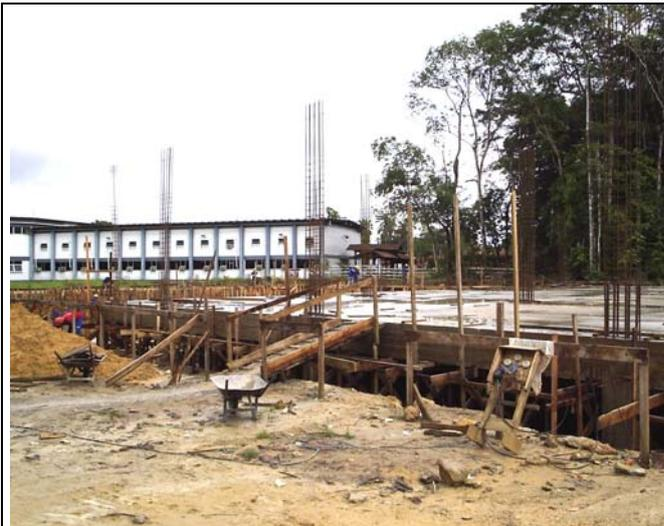
Vista da lateral nos fundos da obra. Laje do pav. térreo do laboratório de Arbovírus.
