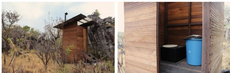
Figura 14: Banheiro seco da trilha das Sete Quedas
