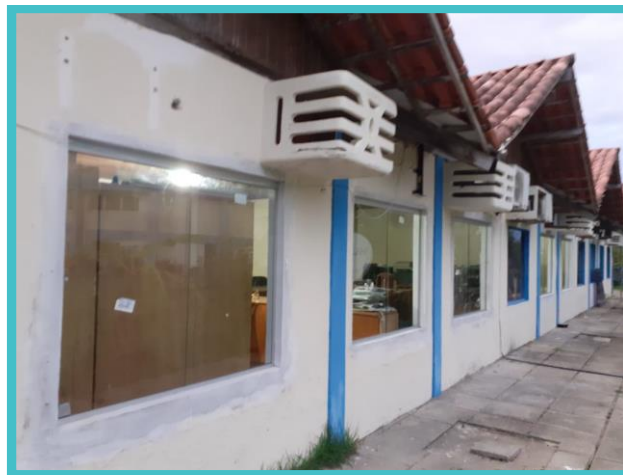
Figura 33: Janelas do prédio das salas, laboratórios e outros
