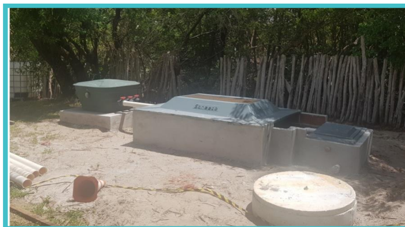
Figura 34: Sistema de esgotamento sanitário
