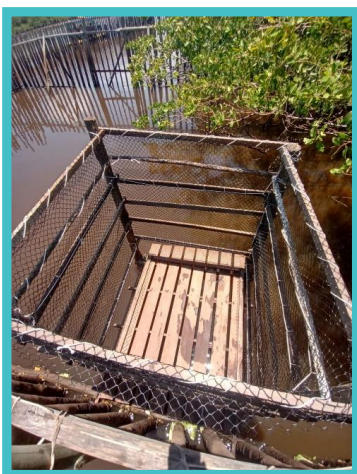
Foto 10: Área construída para armazenamento de capim. Fotos: Bruno/APACC
