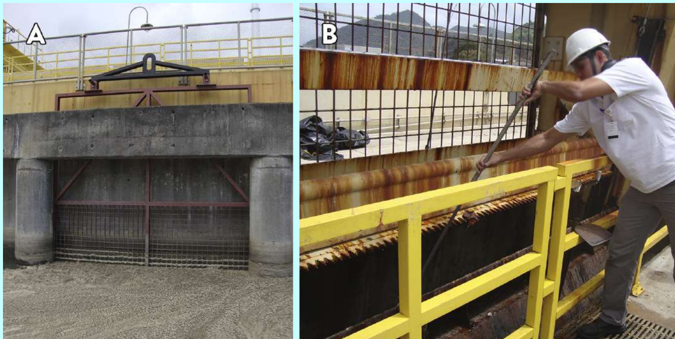
Figura 19: Exemplo de grades de proteção instaladas na galeria de captação de água do mar para o sistema de resfriamento da Usina de Angra. A – Detalhe da grade externa; B – Verificação de capturas incidentais de tartarugas durante a inspeção para retiradas de resíduos da grade interna. Fonte: Acervo Centro TAMAR/ICMBio.
