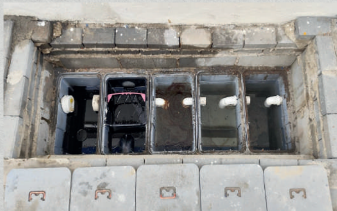
Figura 41. Caixa Separadora de Água e Óleo (SAO) retendo água oleosa. Fonte: Instituto de Pesquisa e Reabilitação de Animais Marinhos (IPRAM).
