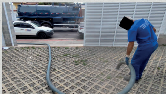
Figura 42. Coleta de resíduo líquido armazenado em fossa impermeável. Neste exemplo, de material não oleado. Fonte: IPRAM.
