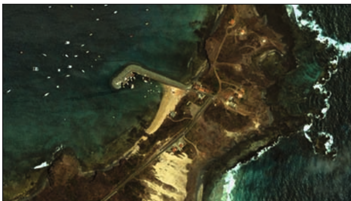
Figura 1.13. Assoreamento à retaguarda da bacia de evolução portuária de Santo Antônio e processo de erosão costeira lateral, na Ilha de Fernando de Noronha.
