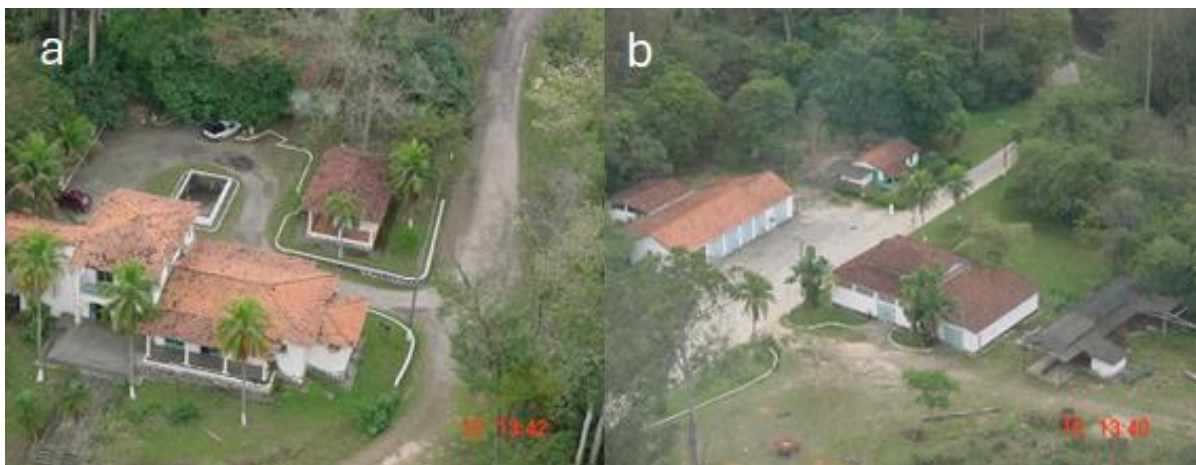
Figura 22 - Estruturas de apoio na Floresta Nacional Mário Xavier, Seropédica, RJ. a) Sede administrativa – câmara fria – centro de vivência – viveiro florestal; b) Oficina de carpintaria – galpão garagem – oficina mecânica.
