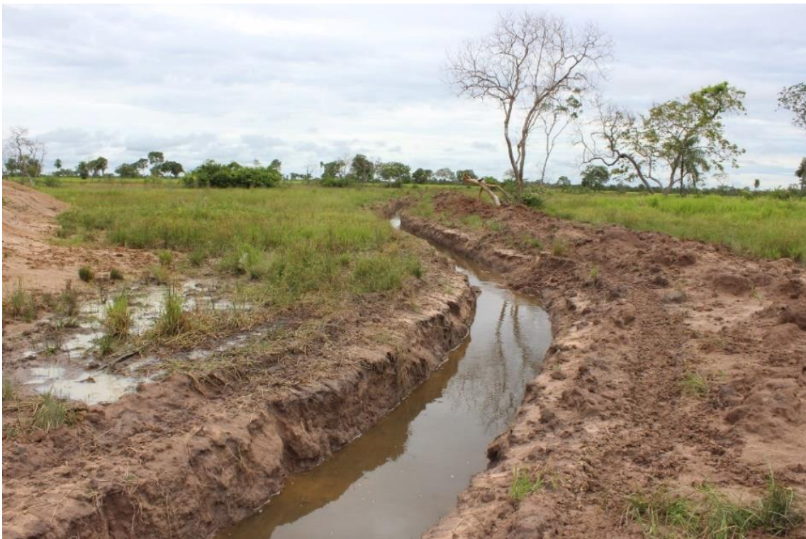
Figura 21: Vista de uma obra de drenagem na planície pantaneira do município de Cáceres, Mato Grosso. (fonte: INAU, 2018).
