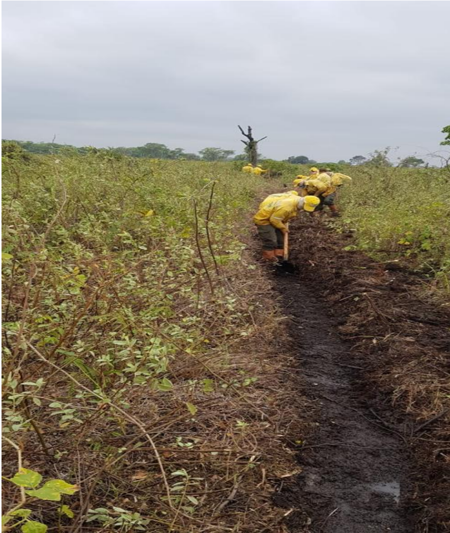
Figura 29: Trincheira sendo construída (fonte: acervo ESEC de Taiamã).
