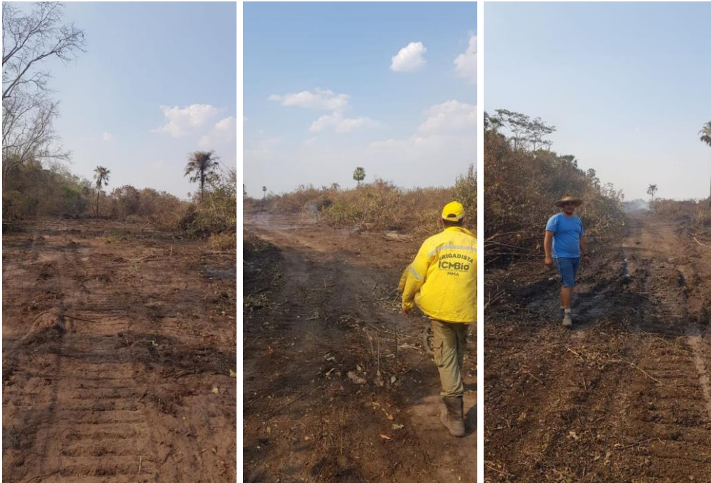
Figura 28: Aceiro construído por trator de esteira na fazenda Descalvados (fonte: acervo ESEC de Taiamã).
