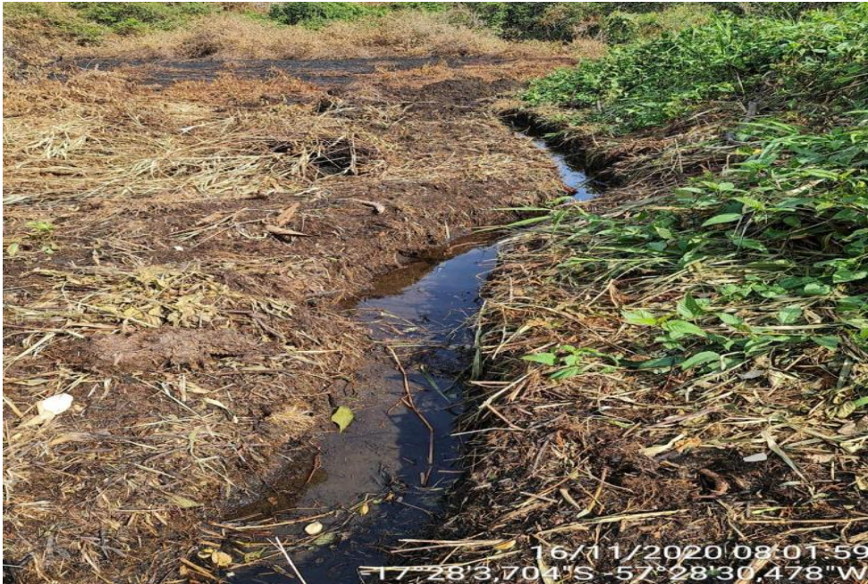
Figura 30: Trincheira pronta isolando área a ser protegida (fonte: acervo ESEC de Taiamã).
